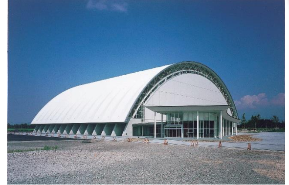
富山県総合運動公園 屋内グラウンド
