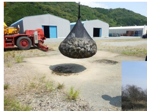
耐候性大型土のう施工
