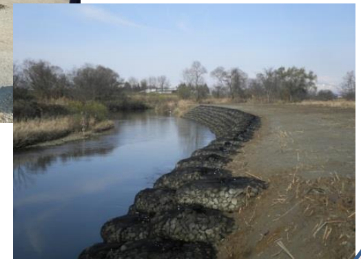
バイオ洗堀防止材施工例
