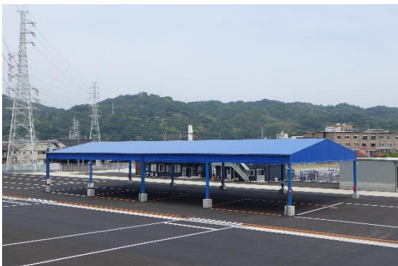
朝日機材国府津管理センター 荷捌き場
