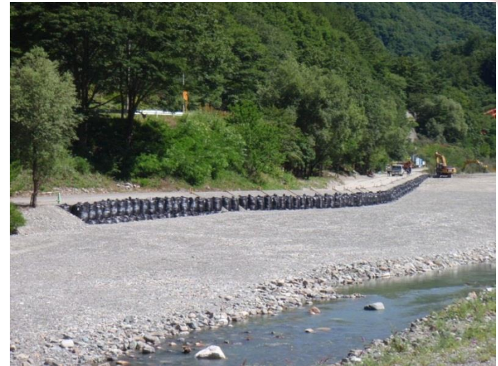
耐候性大型土のう施工
