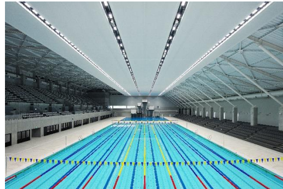
日環アリーナ栃木 屋内水泳場
